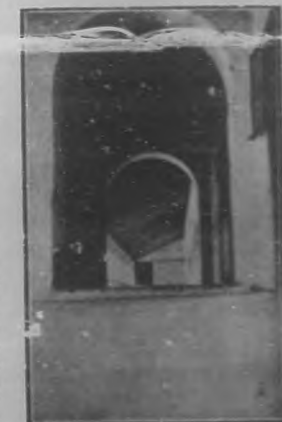
Galerías y más galerías muestran sus sombrías arcadas.
