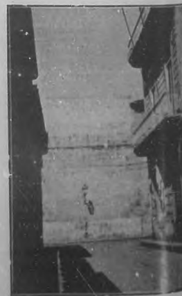
La calle de Progreso, que muere en la tapia desnuda y triste del Convento.
